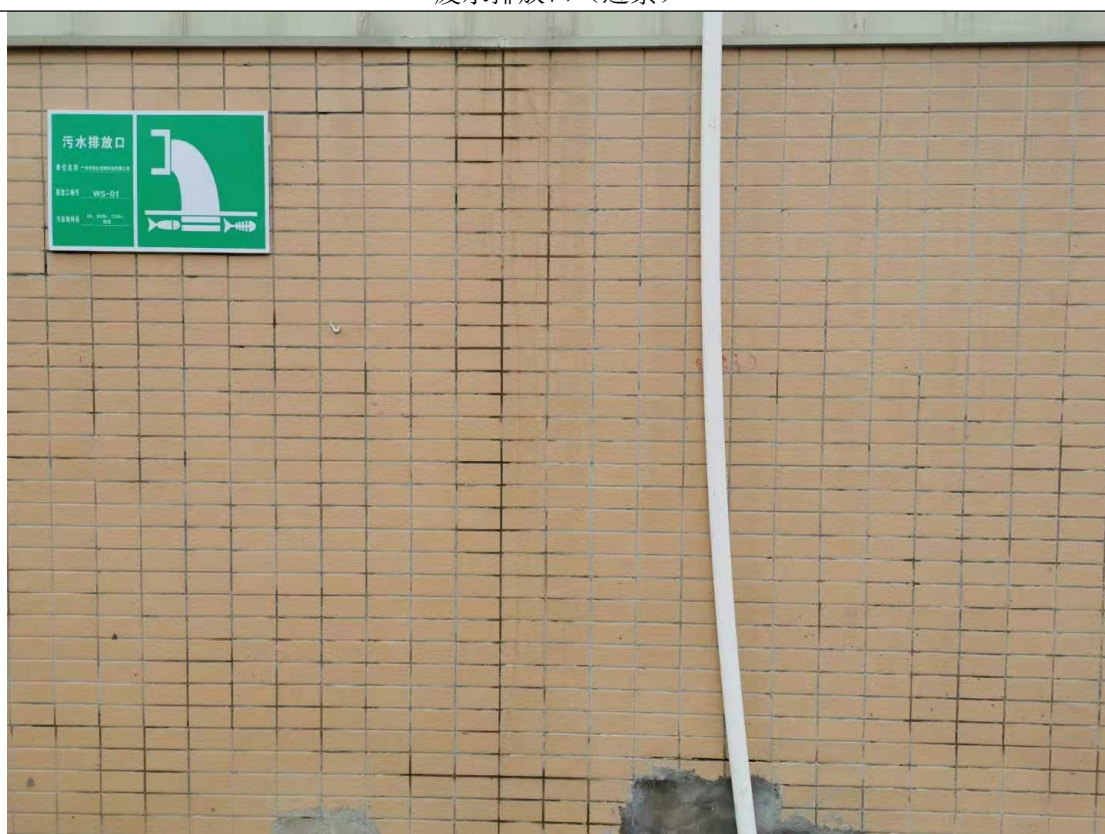
废水排放口（远景）
