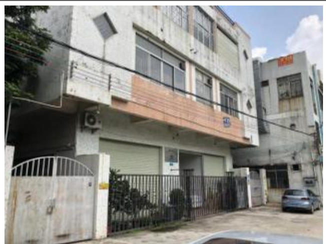
项目正面（3层厂房的首层）
