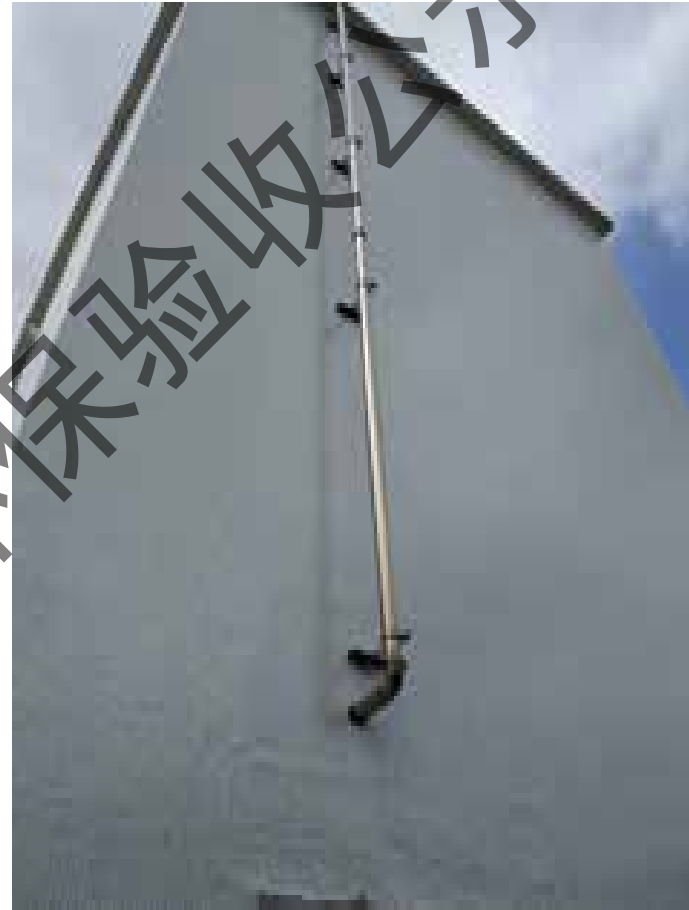
发电机烟气排气筒
