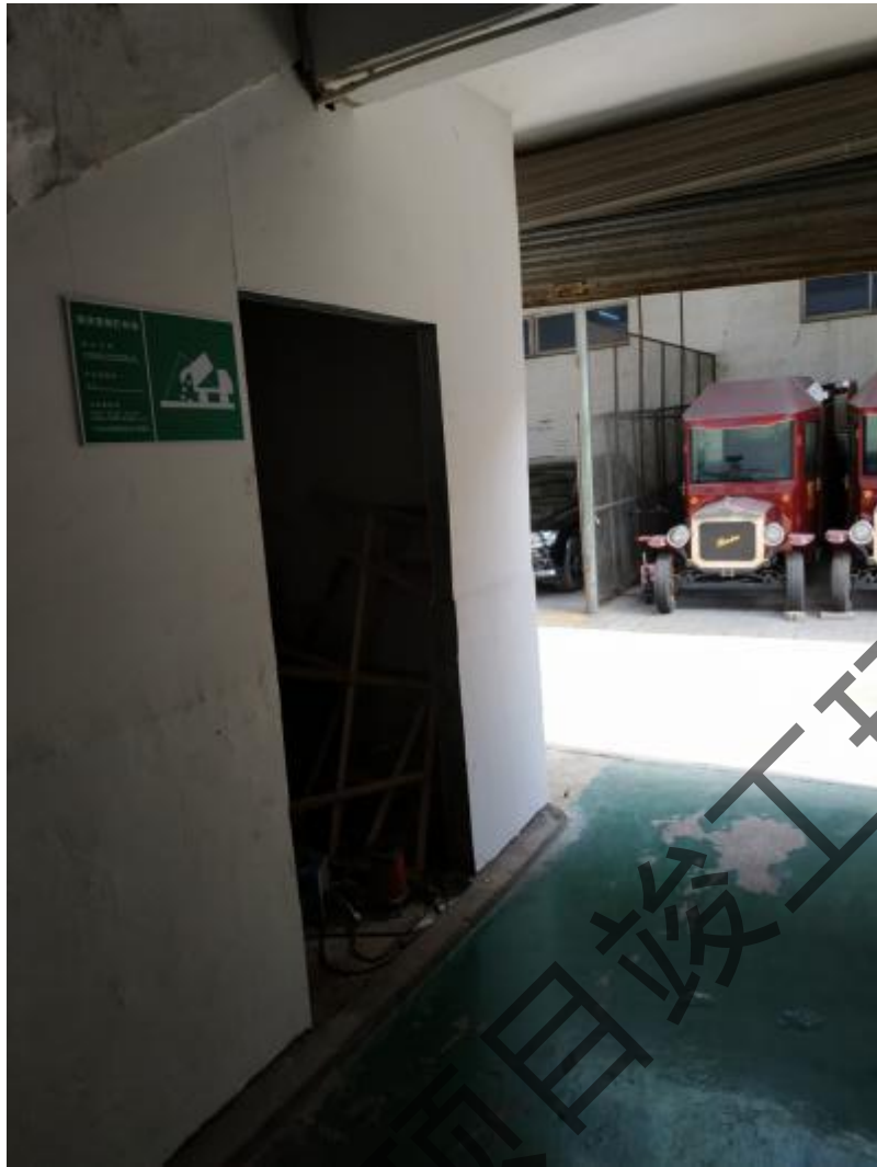
一般固废贮存场
