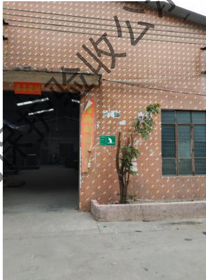
生活污水排放口 远照
