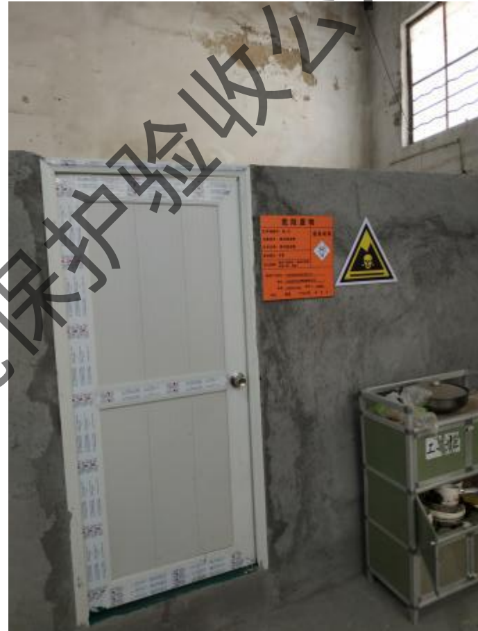
危险废物贮存场所（危-01）远照
