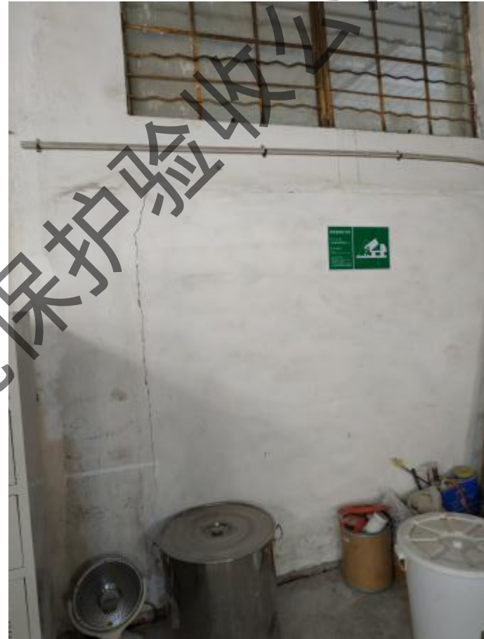
一般固体废物贮存场所（固-01）远照
