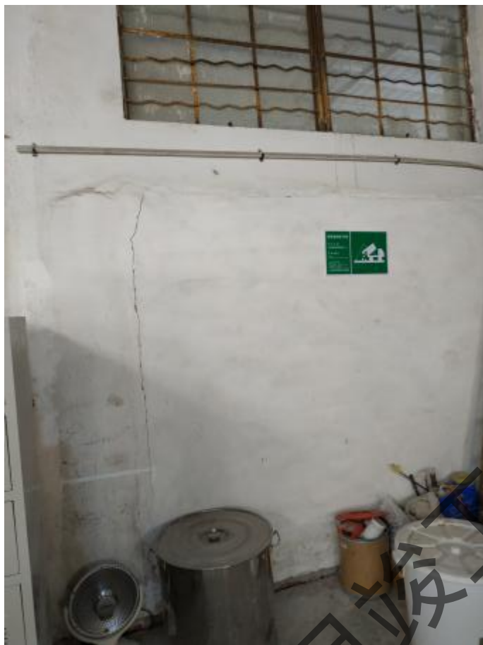
一般固废贮存场
