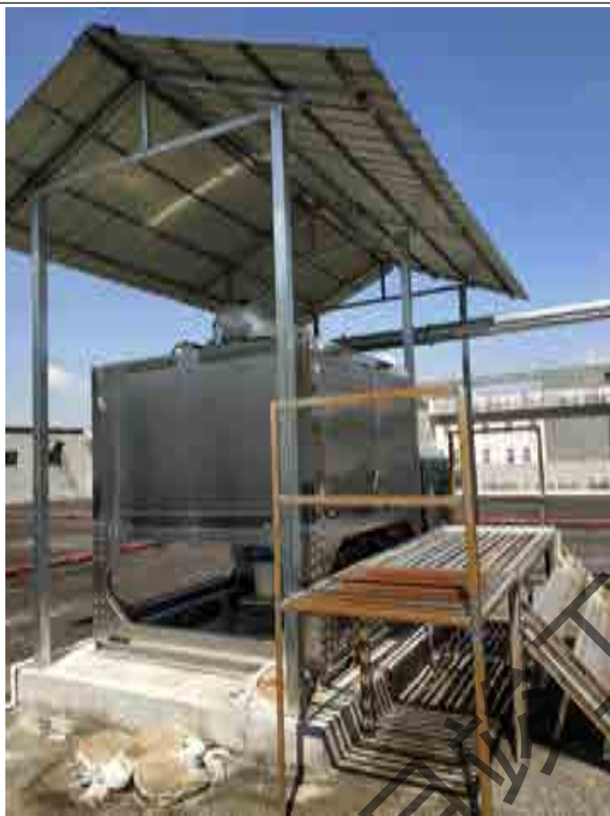
活性炭离线脱附催化燃烧净化装置
