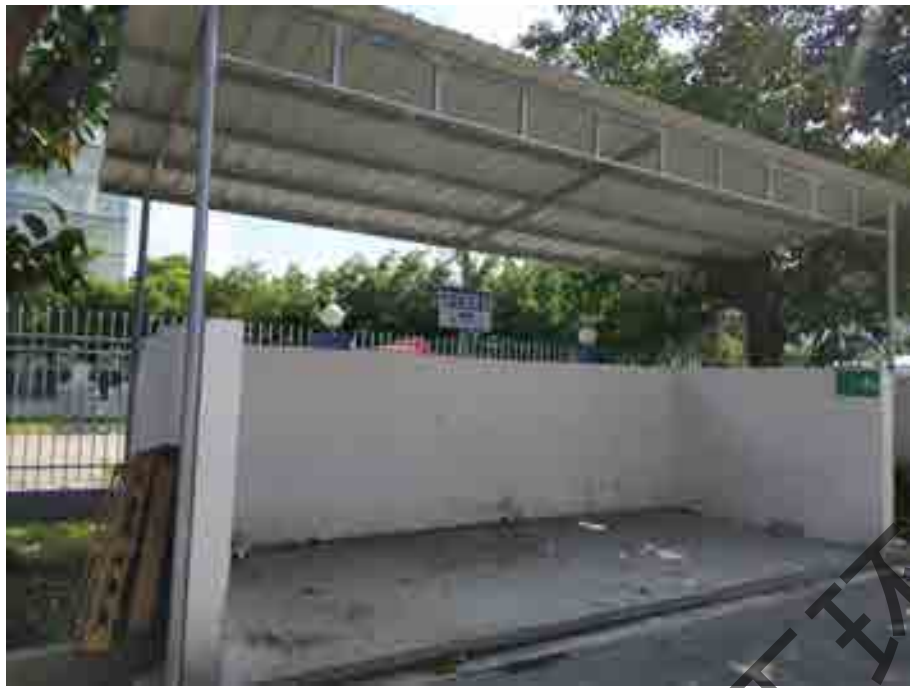
一般固废贮存场
