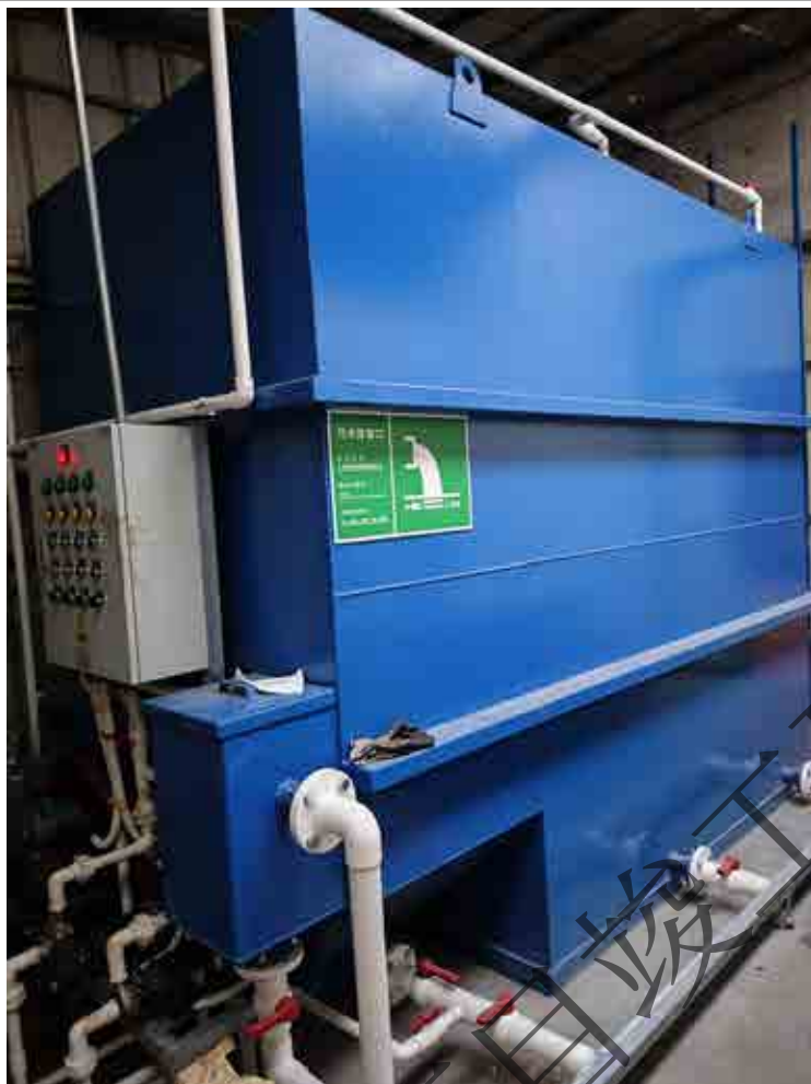
生活污水一体化污水处理设施
