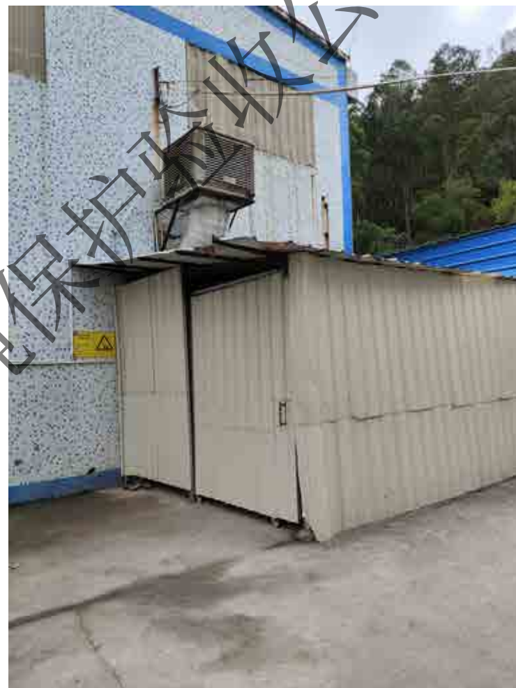
危险废物暂存场
