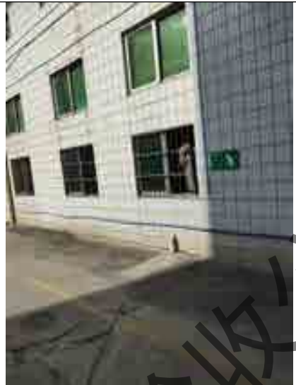
生活污水排放口 DW001 远照
