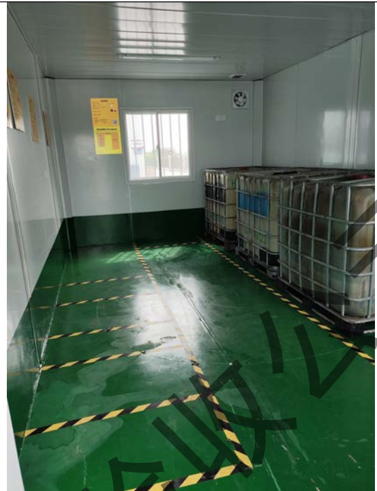
专用危险废物贮存场及地面防渗
