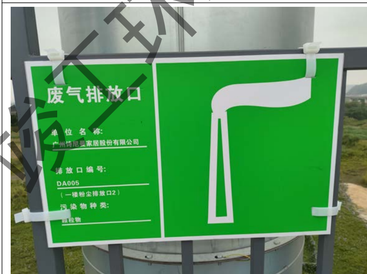
首层粉尘废气排放口 2 DA005 近照
