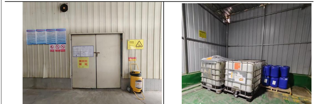
危险废物暂存间
