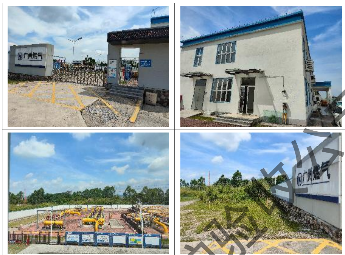
图 2.3.3-2 珊瑚门站现场照片
