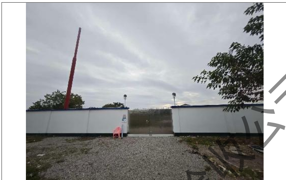
图 2.3.3-16 鹤岗阀室现场照片
