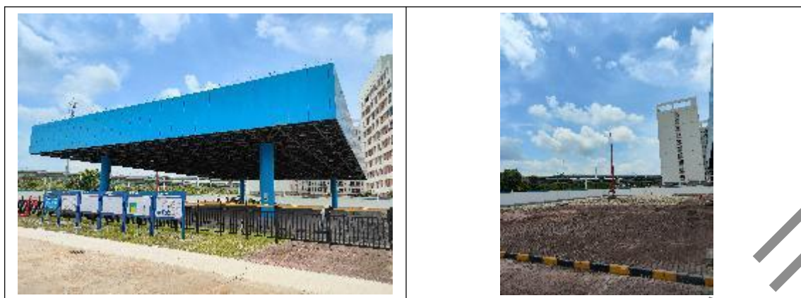
图 2.3.3-4 东升分输阀室现场照片
