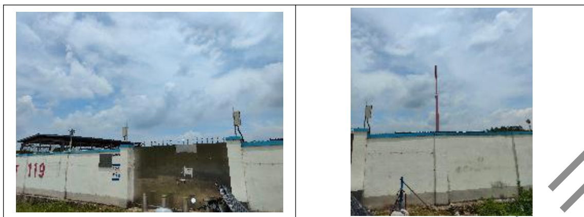
图 2.3.3-6 白坭阀室现场照片
