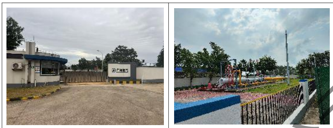
图 2.3.3-26 北兴门站现场照片
