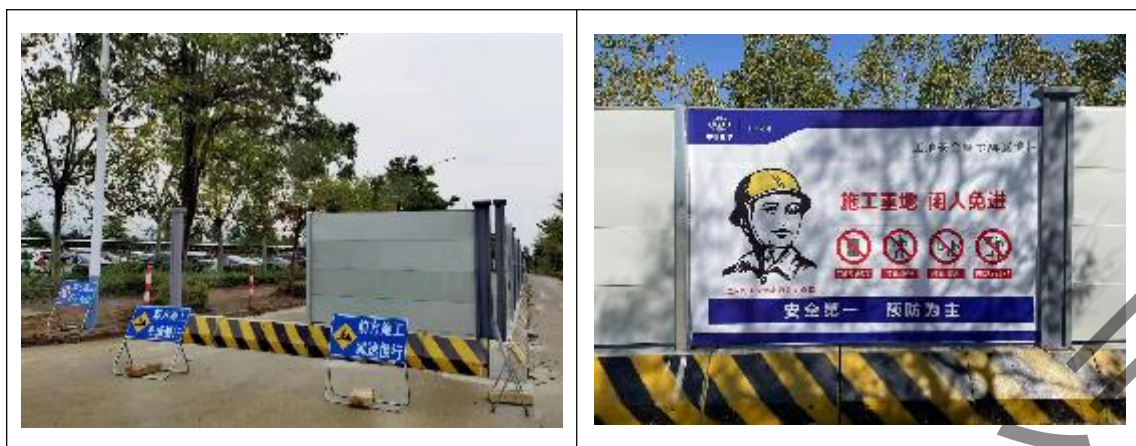
图 7.2-1 施工现场照片
