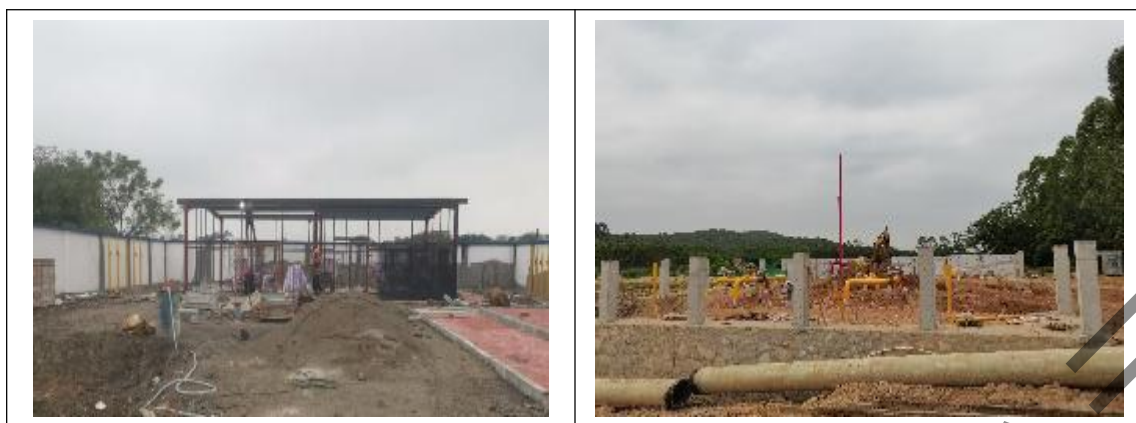
图 2.5.1-5 施工工程现场照片
