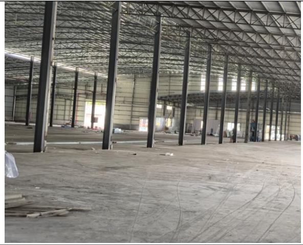
项目内部现状
