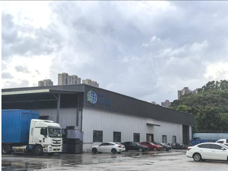
项目所在厂房外部整体情况
