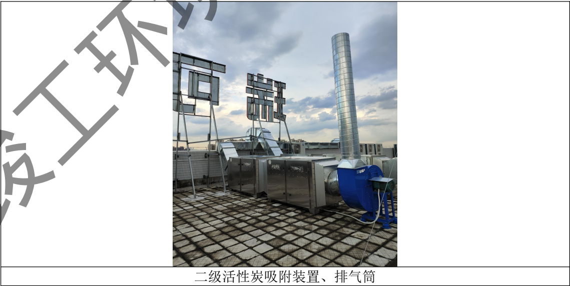
图 4.1-5 废气治理设施现场照片
