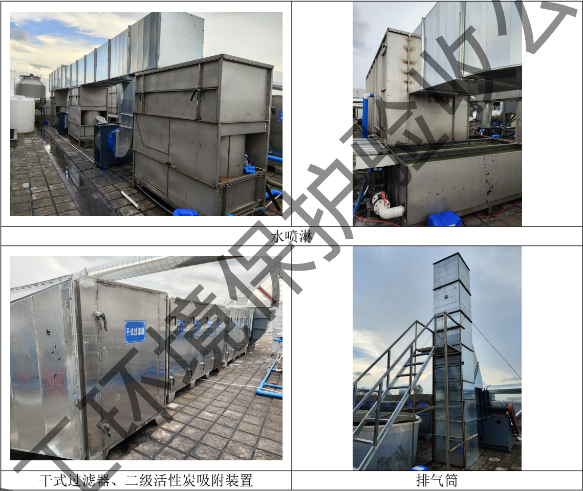
图 4.1-3 废气治理设施现场照片
