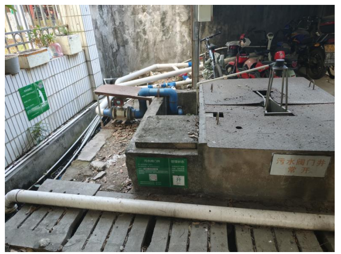
生活污水排放口
