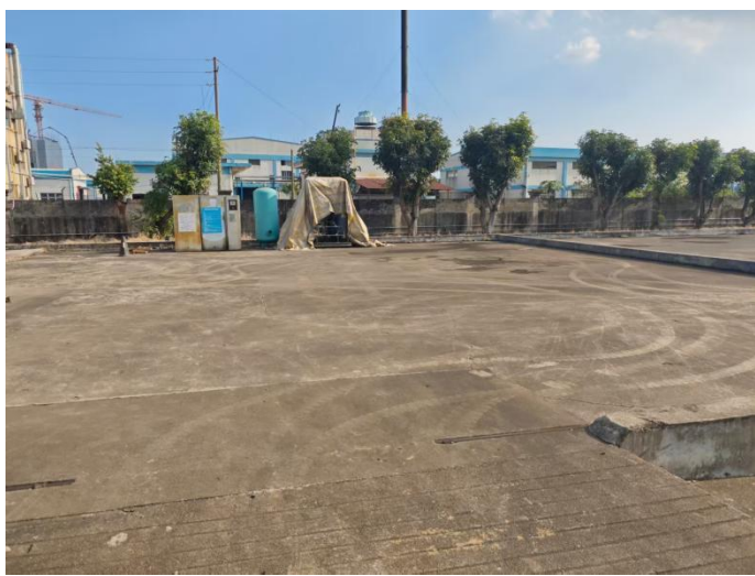
消防泵房用地
