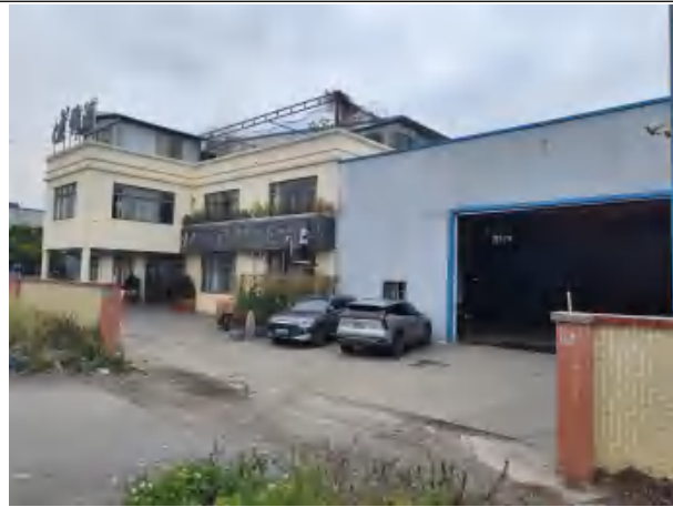
项目东南面-广州市锦澜消防设备有限公司
