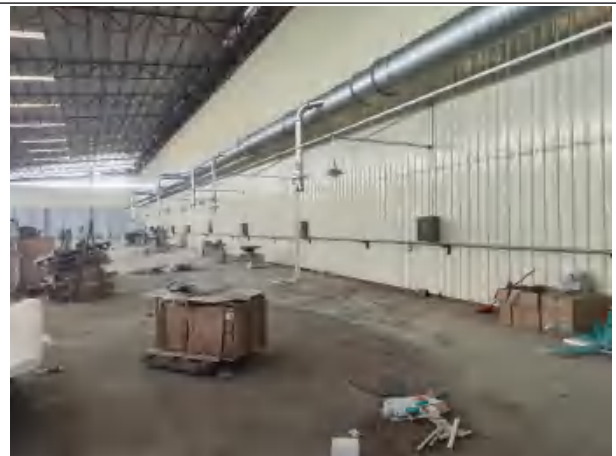
项目厂房现状
