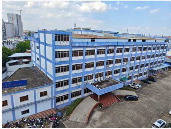
北面 30m: 广州番禺旧水坑技华电子厂 (4F)
