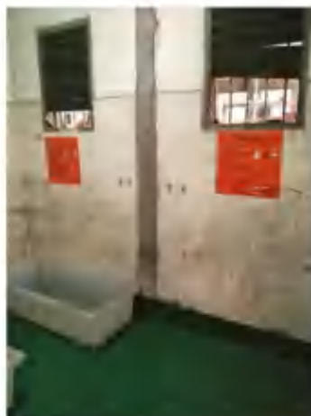
危废仓库内部
