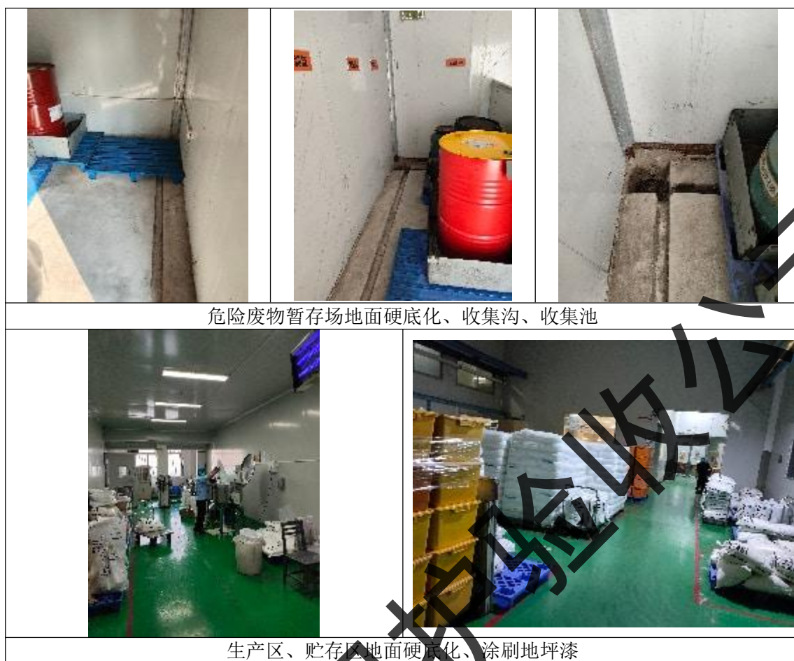
图 4.2-2 区域防渗措施现场情况
