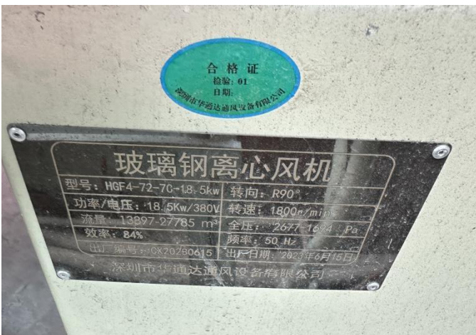
项目内部风机铭牌
