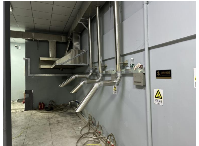
项目现场通风柜、集气罩及集气管照片
