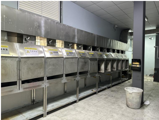
项目现场通风柜、集气罩及集气管照片
